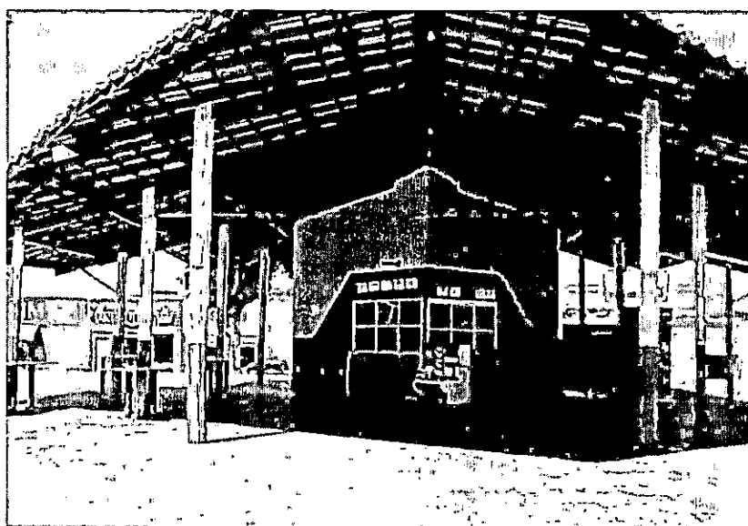
VISTA DA AREA LIVRE COBERTA
