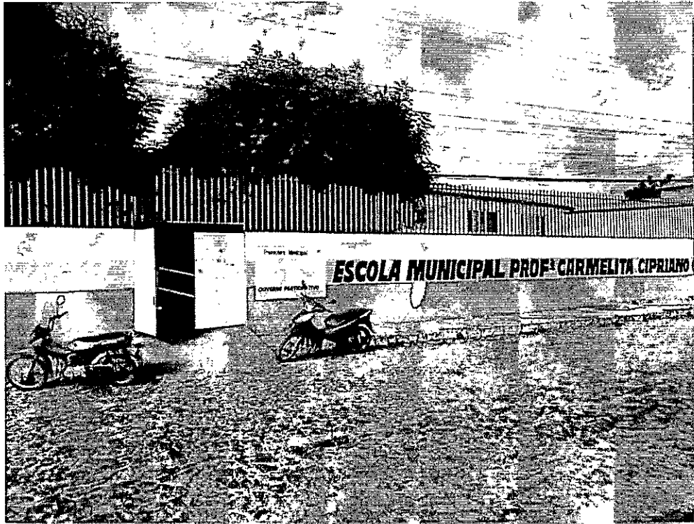
Muro – Fachada Frontal
