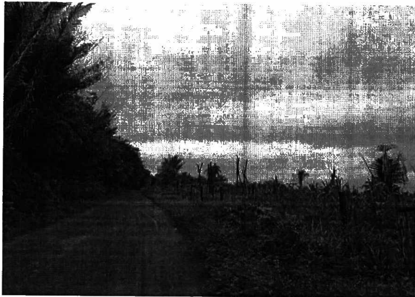
P3 – FINAL DO TRECHO
