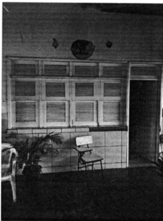
Esquadrias a Substituir
