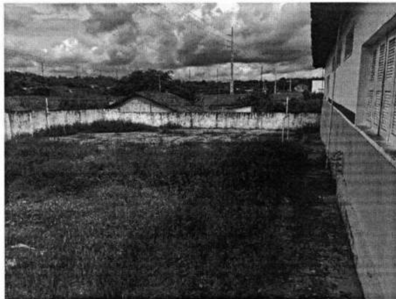
Quadra externa a recuperar o piso.
