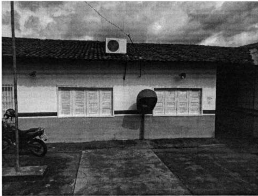
Fachada – Substituir Janela e executar Cerâmica em paredes até 1m.
