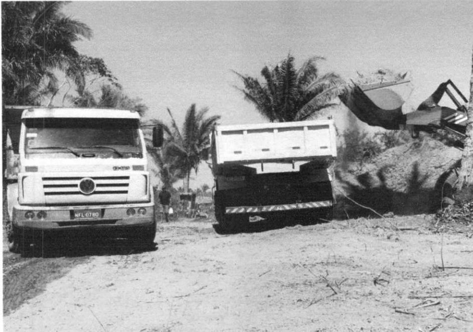
PIÇARRA DE JAZIDA PARA BASE DE PAVIMENTAÇÃO
